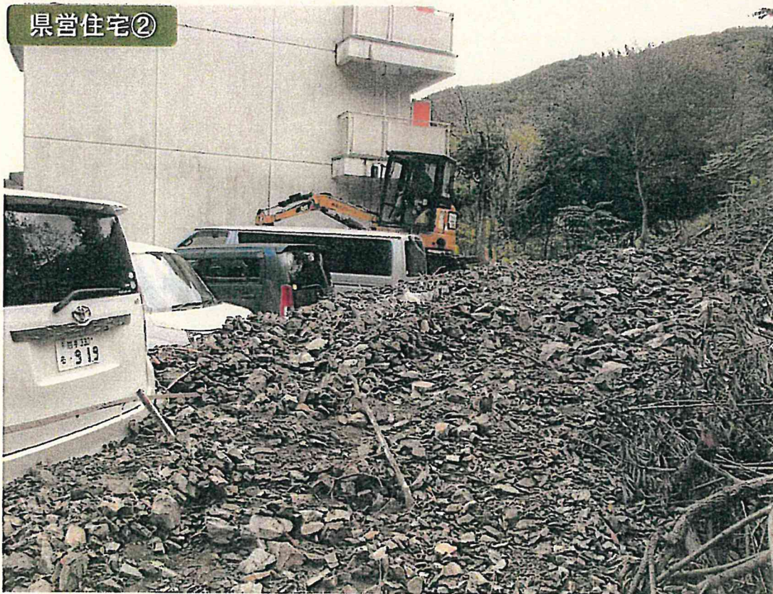
県営上平田アパート（一般公営） 釜石市
