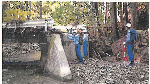
宮古市での調査状況
