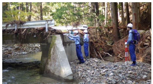
宮古市での調査状況
