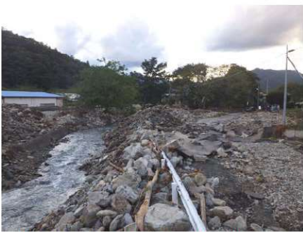
<山田町 準用河川長内川 堆積土砂撤去後>
